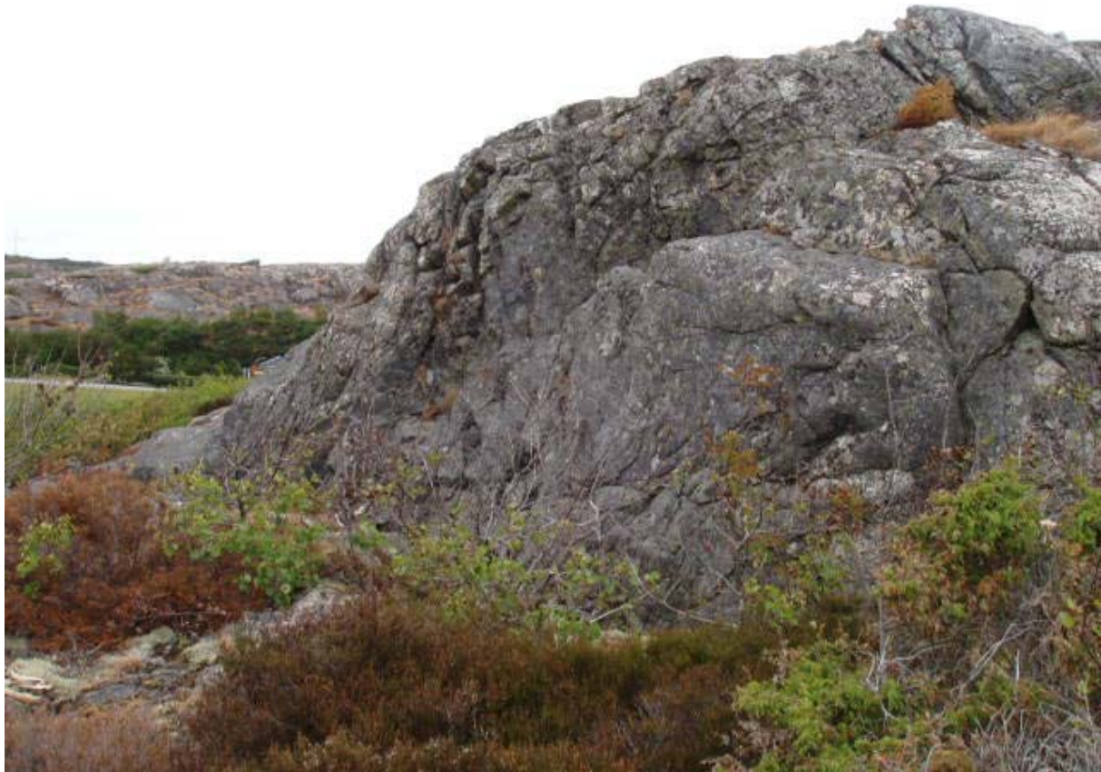
Foto 2: Instabil slänt i vilken hus planeras byggas. Bergssidan är skivigt/blockigt uppsprucken och även på andra sidan hällen är berget brant och något uppsprucket.
