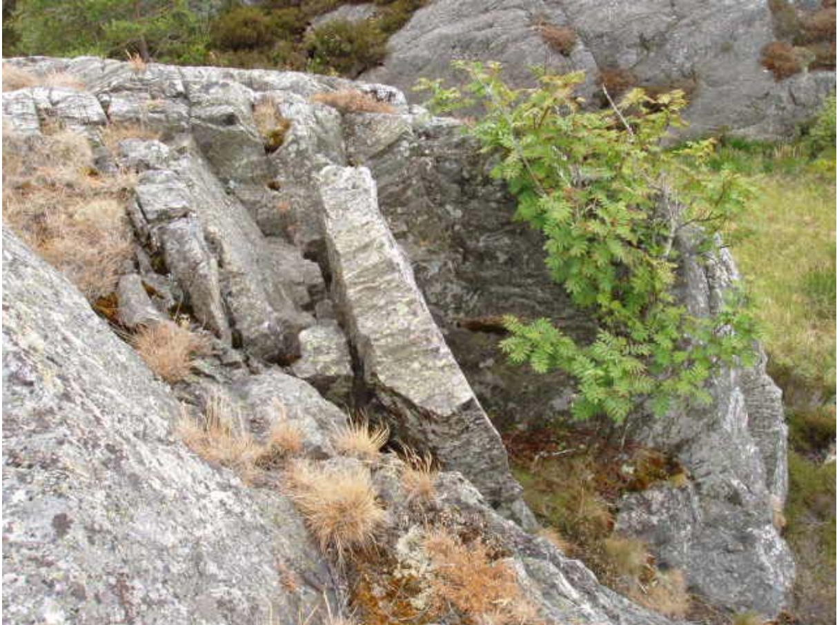
Foto 4: Instabil slänt ovanför planerad väg.
